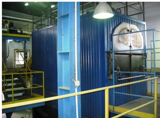
Impianto di teleriscaldamento alimentato a paglia di Lubin (Polonia), con due caldaie da 3,5 MW ciascuna
