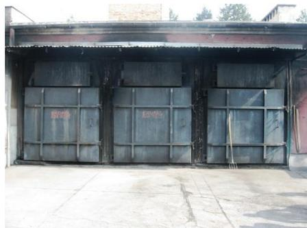
Impianto di teleriscaldamento alimentato a paglia di Zabor (Polonia), con tre caldaie da 300 kW ciascuna
